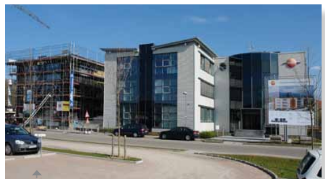
o Aktueller Stand beim Neubau in Kirchzarten
